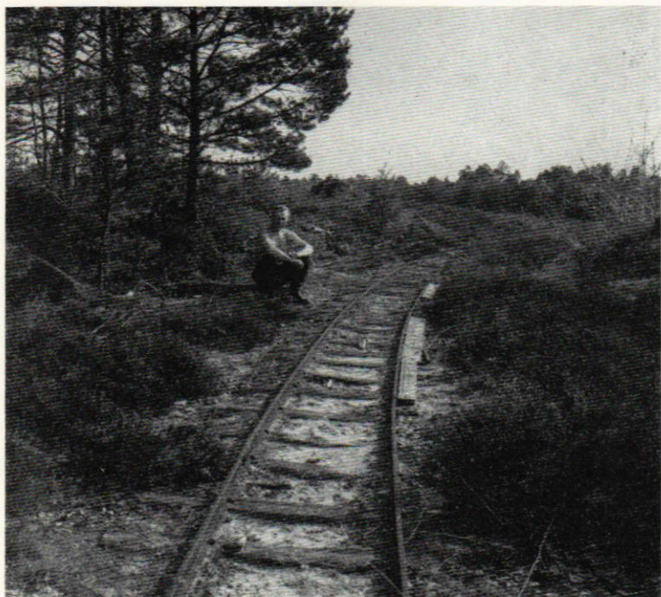
Fig. 1. Skogsjärnväg på Böda kronopark, Öland, med starkt insektangripna syllar 7/5 1956. — Foto: förf.
