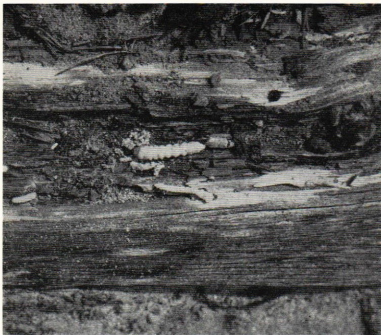
Fig. 2. Inhugg i en syll, i vilken blottats larver av Buprestis 8-guttata L. i det yttre hårda skalet och larver av Leptura rubra L. och sanguinolenta L. i den inre murkna veden. 7/5 1956. — Foto: förf.
